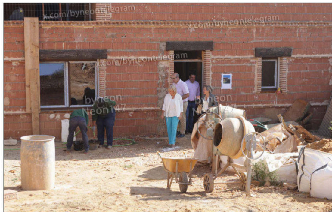
Obras de rehabilitación de los alumnos del programa mixto de formación y empleo. ICAL
